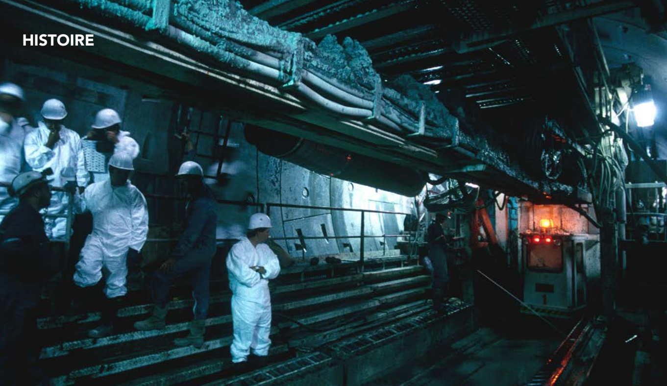
Travaux de percement du tunnel entre Gare de Lyon et Châtelet-les-Halles entre 1993 et 1995.
