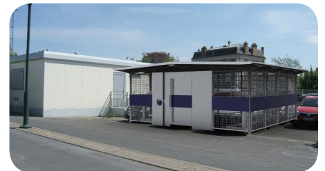
La future station Véligo en gare de Corbeil-Essonnes.
